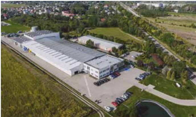
Chechle Pierwsze k. Łodzi – zakład produkcyjny integrujący w jednym miejscu produkcję, logistykę, magazyny, narzędziownię, dział badań i rozwoju, kontroli jakości, BHP
