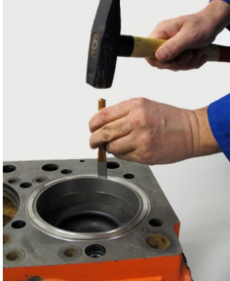
Rys. 4 – Demontaż uszkodzonych tulei cylindra
